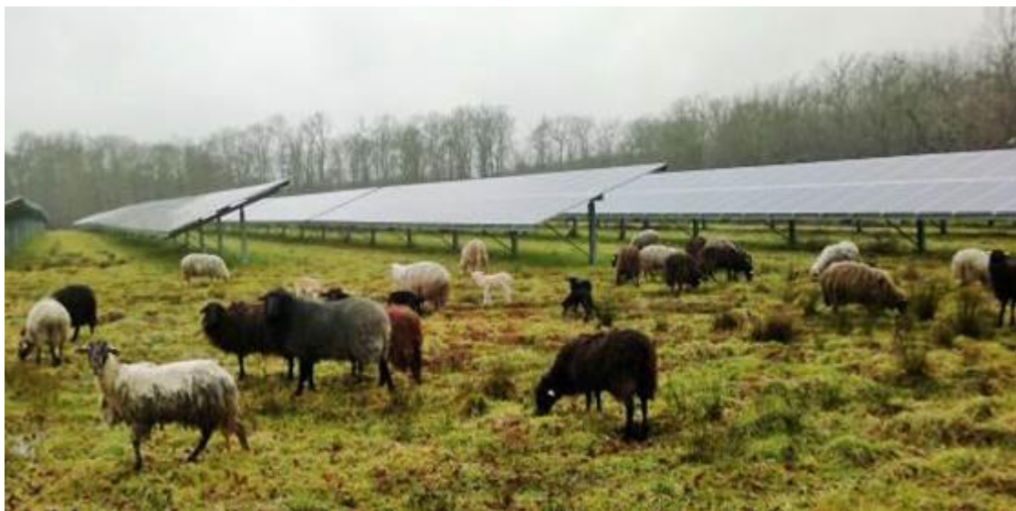
Fig. 1. Moutons à l'abri des modules photovoltaïques (Source : SERGIES)
